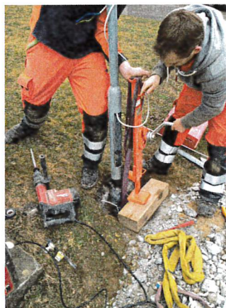
Réparation de socle
