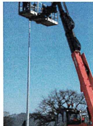
Remplacement de candélabre
